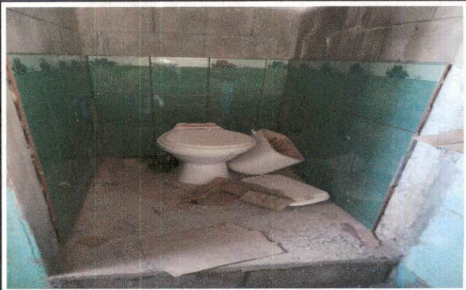
Foto 2: MEJORAMIENTO DE SERVICIOS SANITARIOS Y SUS ACCESORIOS
