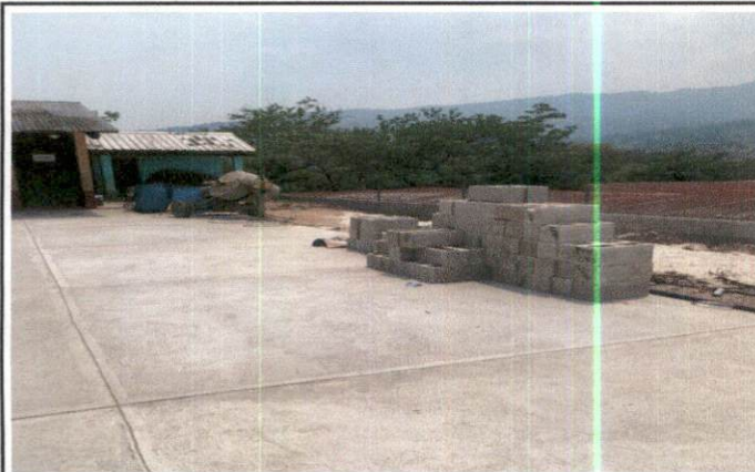
Foto 1: MEJORAMIENTO DE MURO PERIMETRAL
