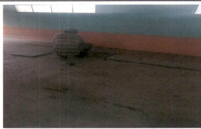
Foto 2: MEJORAMIENTO DE PISO
