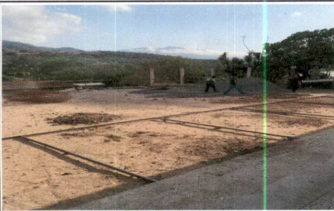
Foto 1: MEJORAMIENTO DE LOSA DE PATIO
